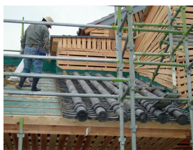
当時の施工の様子
